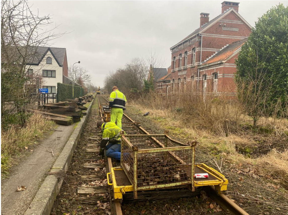
De oude bevestigingen worden met de stumec los gemaakt en verzameld.
